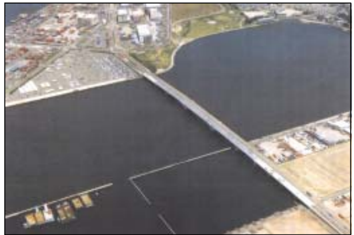
現場航空写真(香椎かもめ大橋)
