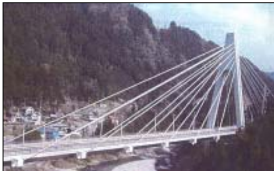
奥多摩大橋(橋長265m)
