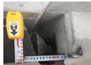
写真-2 ゴム支承の変形
