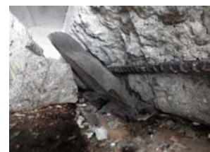
写真-1 打ち下しコンクリートの剥離・鉄筋露出
