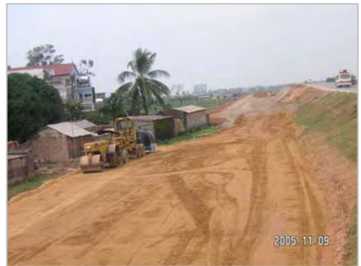
施工中の道路
