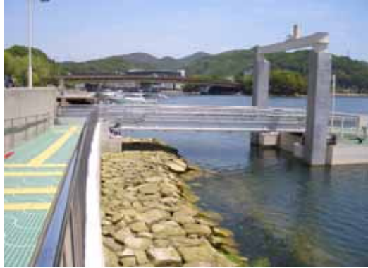
写真-5 取付護岸とスロープ・渡り橋
