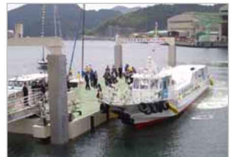
写真-3 船舶接岸状況
