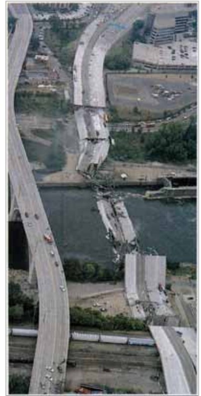
写真-1 落橋状況
