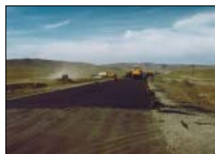
建設中の道路
