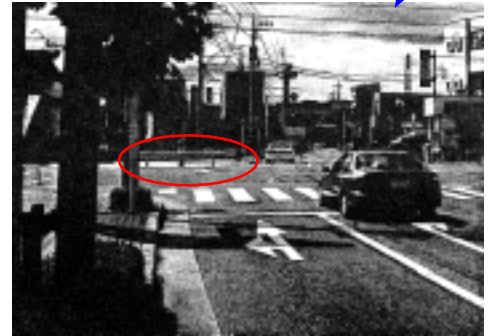
写真-1 改良前状況
