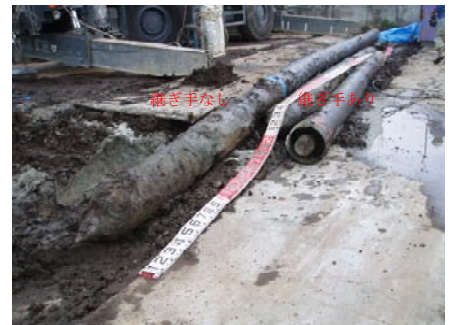
図-2 引抜いた既存杭
