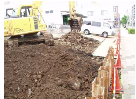
図-1 振るい分け作業
