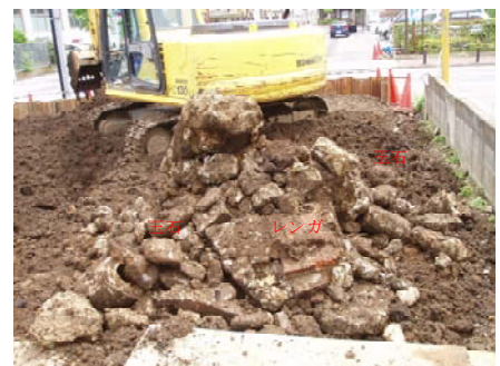
図-3 掘り出したガラ
