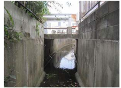
写真-1 補修対象橋梁
