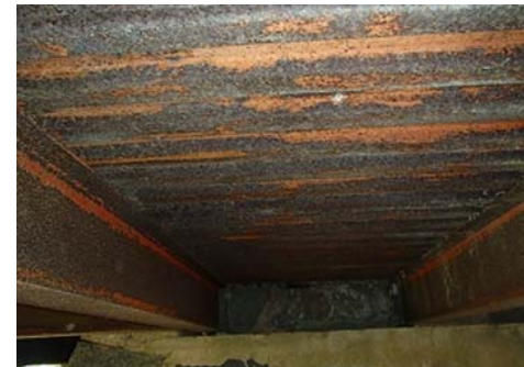
写真-2 床版下面状況 (キーストンプレート)
