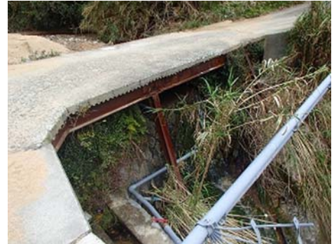
写真-1 対象橋梁全景
