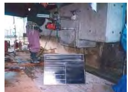
削孔時写真例
