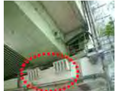
縁端拡幅ブラケット例
