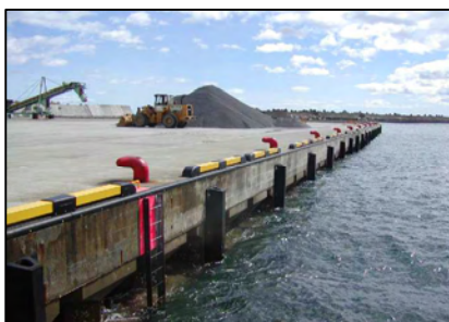
小本港の現況
