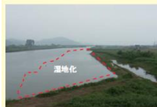
改修後（2007年6月） After reconstruction in June 2007
