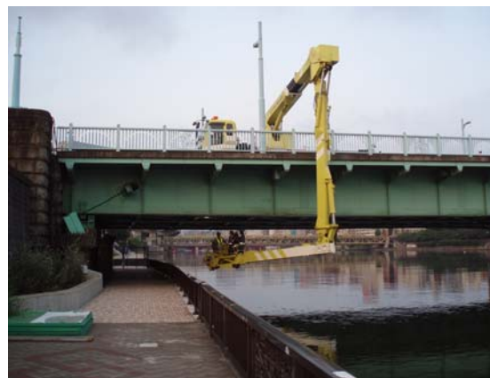
写真-5 点検車による調査
