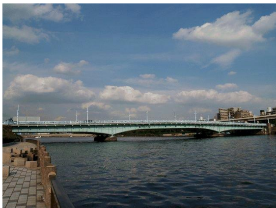
写真-3 言問橋全景
