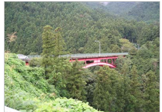
写真-1 鳩ノ巣大橋 (東京都奥多摩町)
