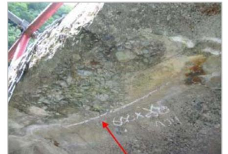
写真-3 桁下損傷状況
