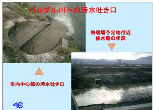
図-5 河川への汚水吐き状況
