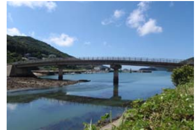
写真-1 対象の橋梁
