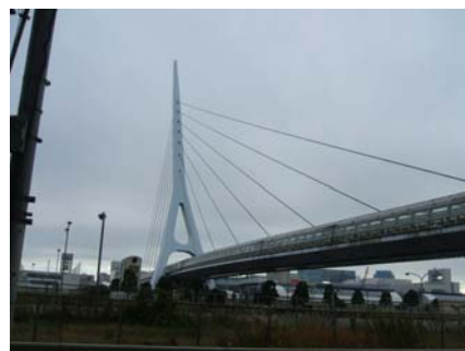
写真-1 斜張橋全景
