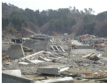
津波により破壊された津波防潮堤
